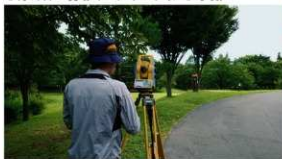
8月11日 測量作業
