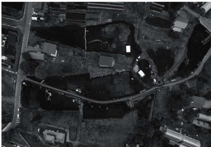
2 道路全景(上61・62区 下51・52区)
