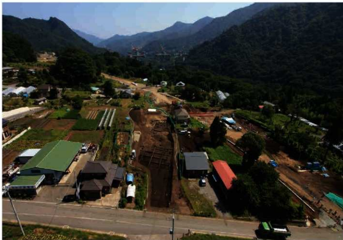
調査区遠景 建設中の不動大橋を臨む（西から）
