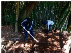
写真68 埋め戻し作業(T5、南から)
