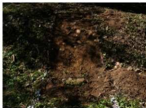
② T1 表土除去状況(東から)
