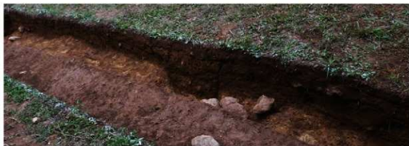
③ T1南壁土層断面(北から)
