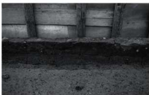
4. 30列南北ベルトAN-30区北側土層断面（東から）
