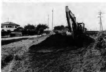
4 富岡作業風景 東から
