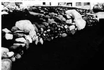
5 富岡2号溝石垣近影 西から
