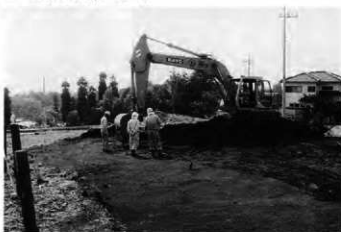
3 富岡作業風景 北から
