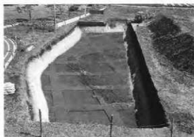
A区F P 混土除去面 (南から)
