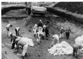
A区F P除去作業
