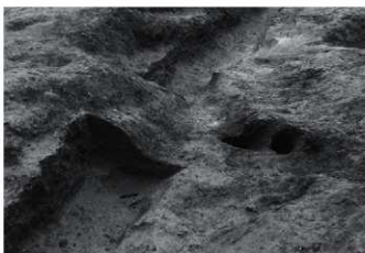
8 1号水路断面B 東から
