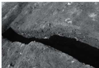
8 同 部分 西から
