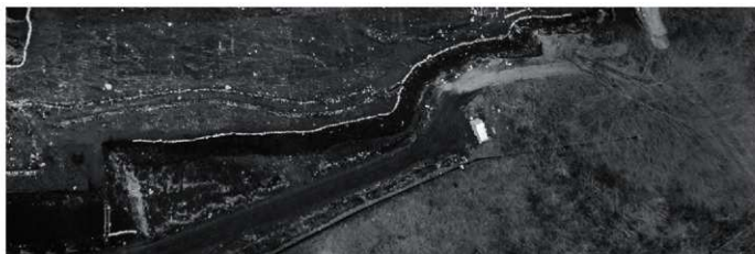
5 7号道・1号水路東部 上が北
