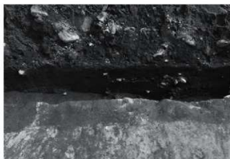
7 同部分 北から
