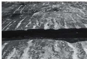
4 同 部分 西から
