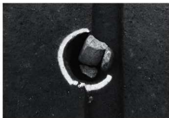
4 2号建物P6断面 南から
