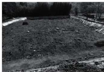
5 第2区画西南部部分 西から
