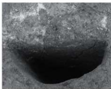
6 ビット列P3断面 南から
