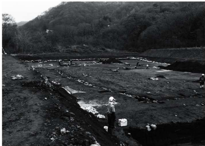
1 2号水路西部 西から
