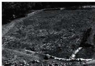
3 同 第2区画西北部部分 西から
