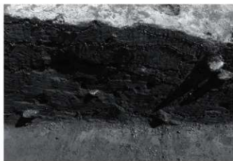
3 同 部分 西から
