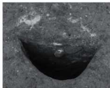
7 ビット列P4断面 南から
