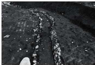
1 7号道・1号水路東部2号石垣部 東から
