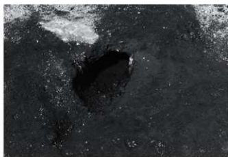
7 2号建物P4 南から
