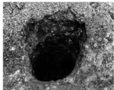
3. 6号ビット全景(北から)
