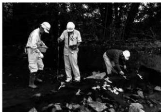
5. 測量作業(南から)
