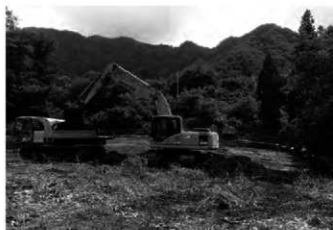
8. 表土掘削(北から)
