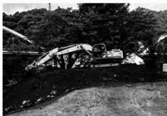
6. B区北西部埋め戻し作業風景(北から)
