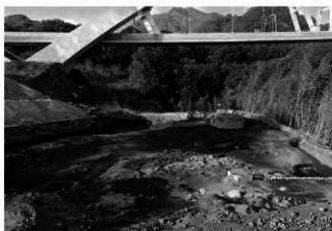
6. B区2面全景(南から)
