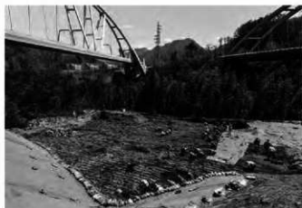
3. B区2面調査風景(北西から)
