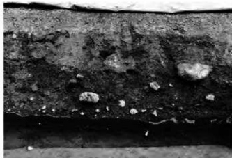
3. C区4号トレンチ(北から)
