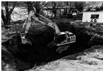
2. E区1面掘削作業風景(北から)
