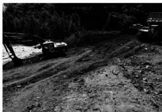
5. D区表土掘削風景(東から)
