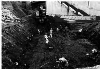
1. C区1面東部調査風景(北から)
