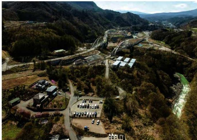
尾坂道跡遠景(東上空から)
