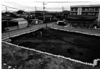
8. 11区作業状況(南から)
