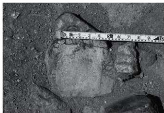
4 5号建物礎石No27に残った床束痕跡約12cm
