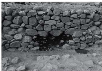
5 16号石垣 南から
