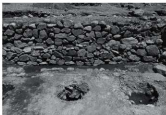
4 16号石垣上段と下段で使用される石の大きさが違う 南から
