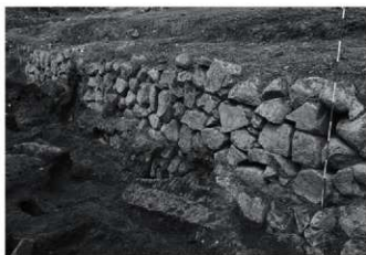
2 5号建物土壁2 南東から
