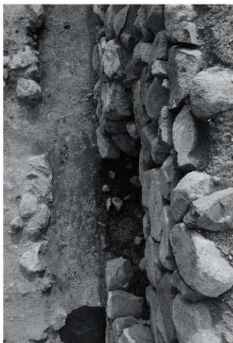
7 16号石垣上段と下段の石垣で位置がずれている 東から
