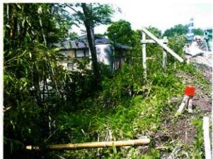
調査前の状況
