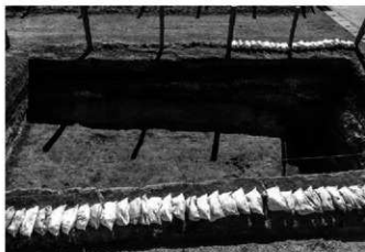
3. 2区3区画2面全景(北から)
