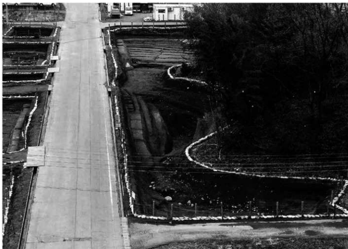
1. 1区5面全景(北から)
