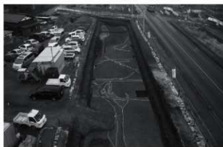
5 P区 全景 (西から)
