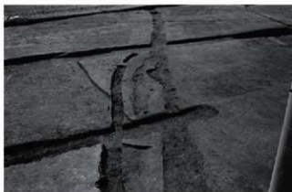
5 B区1面 2~4号溝 全景(北から)
