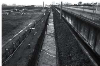
5 E区3面 全景 (東から)
