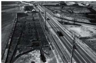
1 B区1面 全景(東から)
