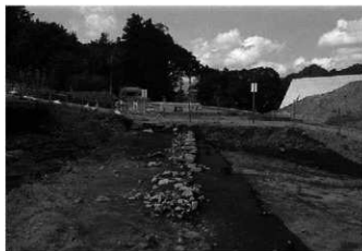
6 20区18号石垣全景(東から)
