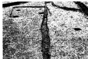
第81号溝 (北東から)
