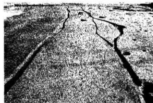
第50・52・53号溝 (南西から)
