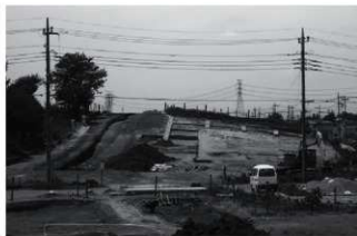
東斜面トレンチ全景（東から）
