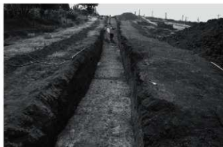
東斜面トレンチ全景（東から）
