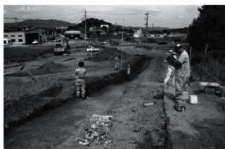
東斜面トレンチ調査風景（西から）
