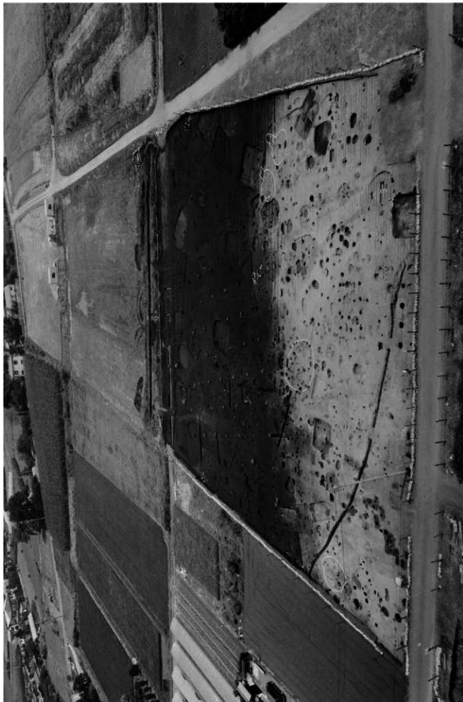
本線IV区・県側道4区全景
