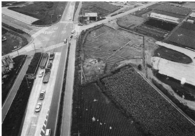
1. A6区北区周辺空中写真(南東から)
