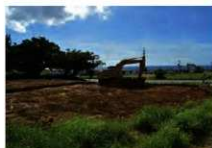
遺構掘削 (工区2)
