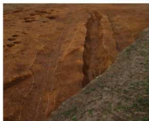
SD1-3 完掘状況 東より
