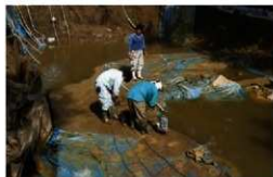
1トレ排水作業 (11/5)
