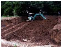
2トレ埋め戻し作業 (11/25)
