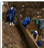
1トレ復旧作業 (11/17)
