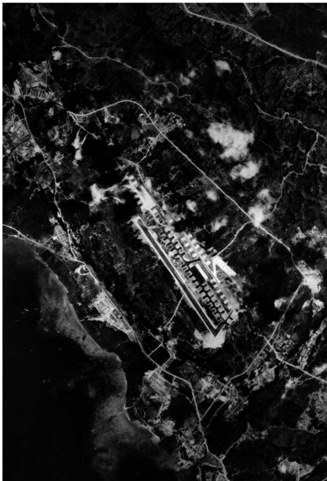
巻頭図版 2 建設中の普天間飛行場（1945年12月）「国土地理院所蔵」
