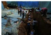
2トレ 西壁修復 (10/15)
