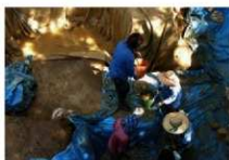
1トレ排水作業 (10/10)
