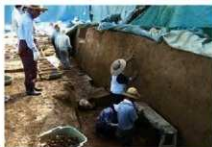
2トレ 西壁修復 (10/20)
