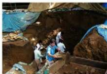
2トレ 西壁修復 (10/20)
