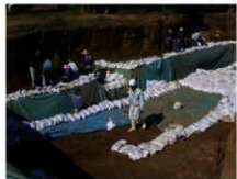
2トレ養生作業 (11/21)
