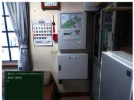
32 受信機設置完了状況（事務所）
