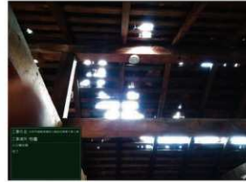
25 火災報知設備設置完了状況（物置）
