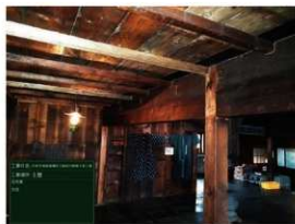
15 空気警報装置完了写真（主屋）
