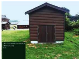
7 ポンプ室設置状況
