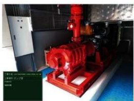
8 エンジンポンプ設置状況
