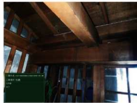
23 空気を設置完了状況（石蔵）
