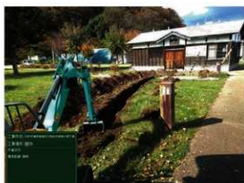
5 電気配線掘削状況
