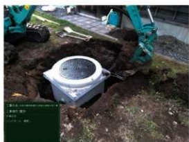
3 ハンドホール設置状況
