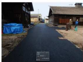
4 舗装完了状況
