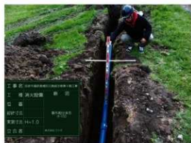
1 消火用配水管設置状況
