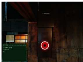
10 火災報知設備点検完了状況（主屋）
