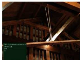
24 空気を設置完了状況（石蔵）
