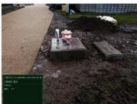
6 消火栓埋設完了
