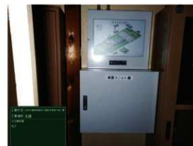
16 耐震検閲装置完了状況（主屋）
