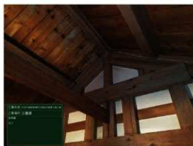
19 空気を設置完了状況（文書庫）
