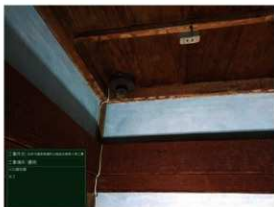
26 火災警知設備設置完了状況（便所）
