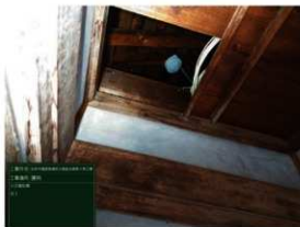
27 火災警知設備設置完了状況（便所）
