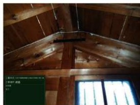
29 空気を設置完了状況（網倉）
