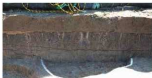
3-3 区西壁 SK3030 断面 東から
