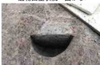
3-1 区 SB3105-SP3374 断面 西から
