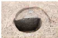
3-1 区 SB3101-SP3263 断面 南から
