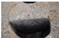
3-1 区 SB3104-SP3401 断面 西から
