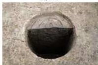
3-1 区 SB3101-SP3265 断面 北から
