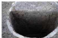
3-1 区 SB3102-SP3240 断面 西から
