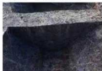
1-2 区 SD3039 b-b' 断面 南東から
