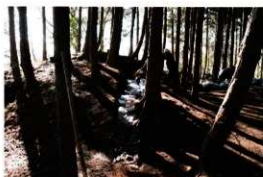
埋め戻し作業
