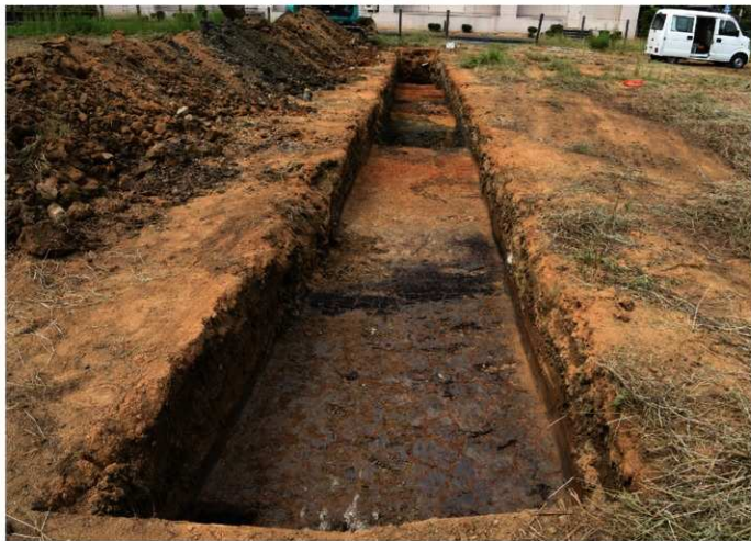
写真2 2区全景 溝検出状況 -西から-
