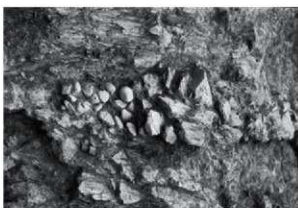
3. 排水溝末端部付近
