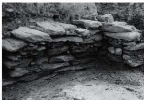
大谷山 27 号墳石室調査状況
