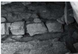
2. 排水溝検出状況（扉石付近）
