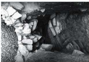
2. 後円部北トレンチ 石室堀方及び裏込め検出状況①
