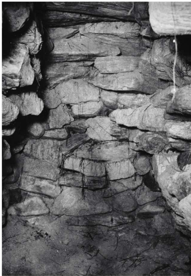
西壁 (第1次調査)
