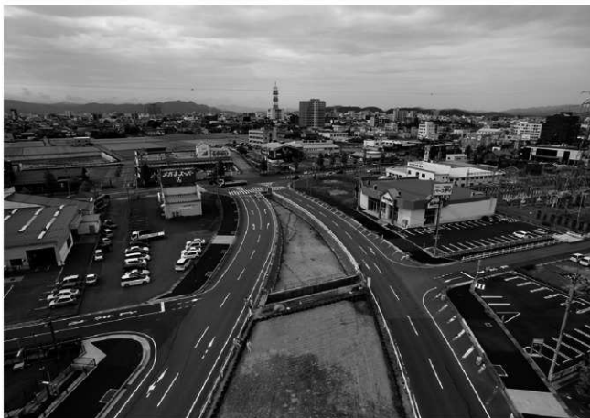
(2) 調査地遠景 (Ⅱ区北方上空より)
