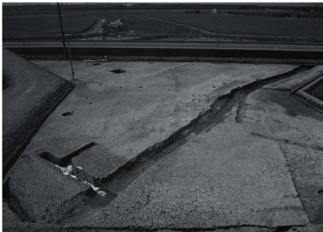
(1) 第IV区域1区 (南東から)
