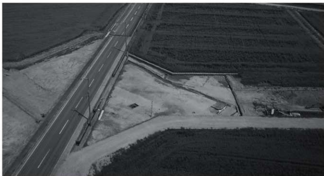
(2) 第IV区域1区(西から)
