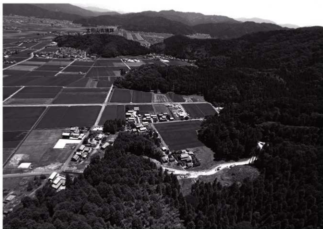
(1) 調査地遠景 (西上空から)
