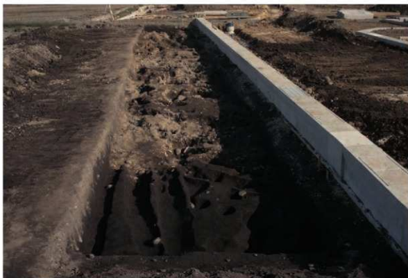
南区道構完掘状態(西より)
