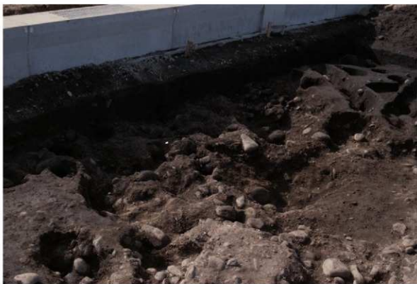
南区 ST1 完掘状態(北東より)
