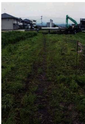
A 区北部調査前風景(西より)
