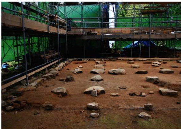
主屋居室部北東調査前風景(西より)
