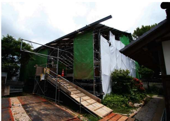
主屋覆屋設置状態(南西より)
