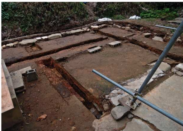
釜屋「釜場」トレンチ掘削状態(南西より)
