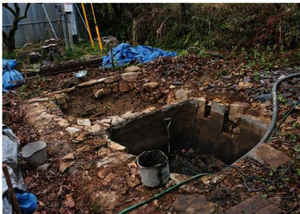
雪隠掘削状態(北東より)
