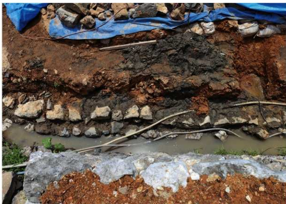
米蔵北部溝石垣検出状態(北より)
