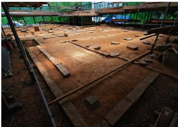
主屋座敷部調査前風景(南西より)
