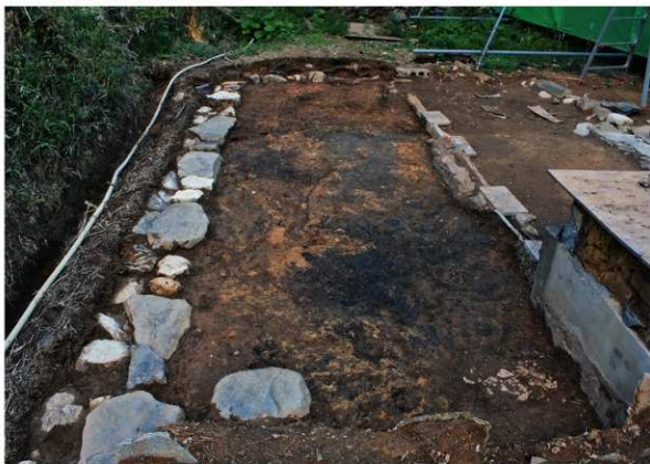
釜屋「釜場」崩落土除去状態(西より)
