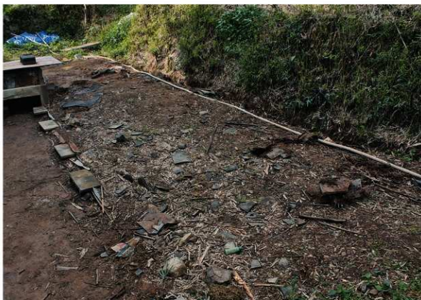
釜屋「釜場」崩落土調査前風景(南東より)
