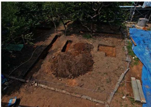
新宅トレンチ掘削状態(北東より)
