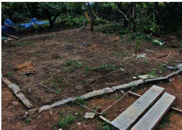
新宅調査前風景(北東より)
