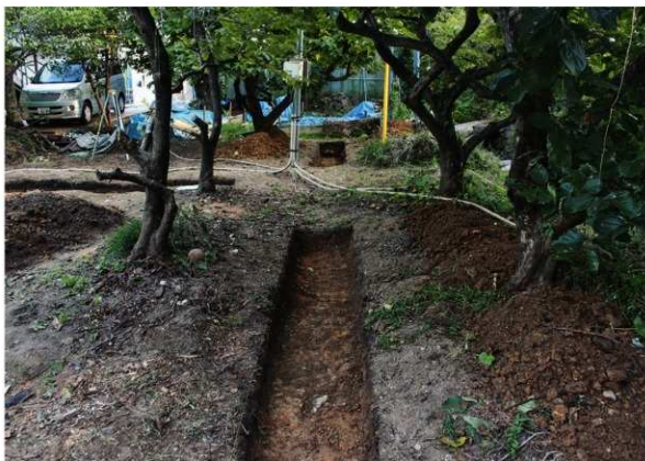
新宅 TR2・3完掘状態(北より)
