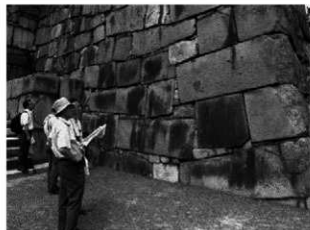
二条城の石垣調査
