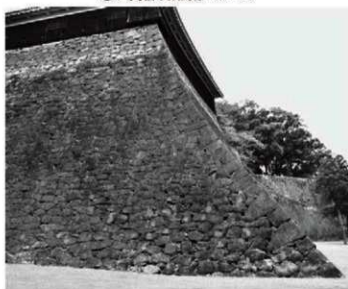
③ 北十八間櫓下北東隅角部 (東から)
