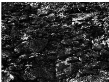
② 徳島城 1期（本丸北面築石部）
