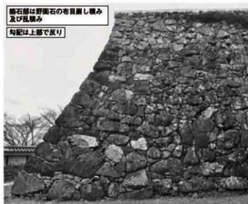
① 本丸北東隅角部（北から）
