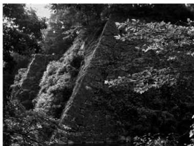
② 上野城藤堂家改修部分（本丸北西隅角部）
