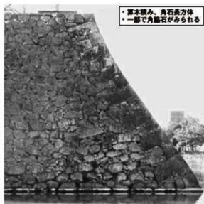
② 大天守台北西隅角部（北から）
