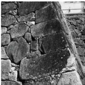
② 同左、角石の表面調整 (南から)
