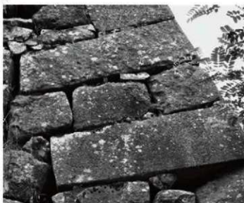
③ 同左、角石・角脇石表面の細かなノミ調整
