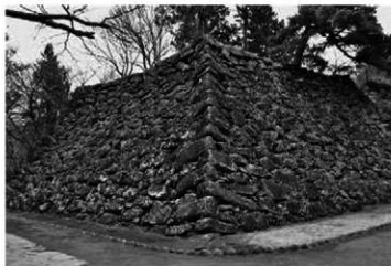
写真 32 小諸城 天守台石垣北西隅角部
