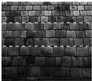
大中小の規格材を用いた四方積（北面）
