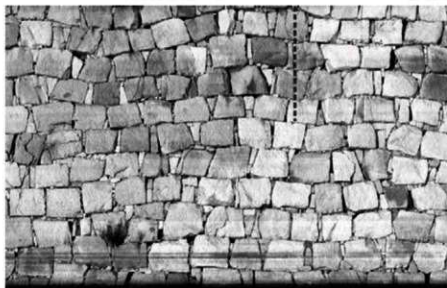
⑤ 同上、南面築石部 ※築石は規格化が進んだ石材による布目積み
