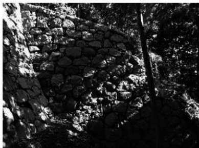
③ 松山城2期 (北登り石垣築石部)
