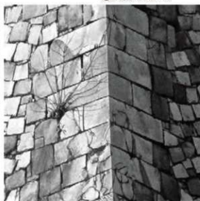
④ 同左、隅角部の拡大 (南東より)
