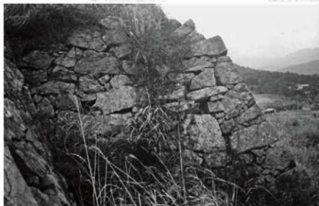
⑤ 同③、左側の隅角部（隙線は僅かに勾配が起きる）
