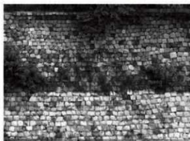
③ 大坂城3期生駒家丁場（二の丸南面築石部〔南外堀〕）
