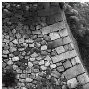
③ 同上、隅角部上部拡大 (北から)
