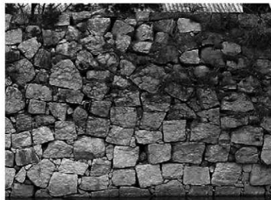
③ 洲本城蜂須賀家改修部分 (下の城北面築石部)
