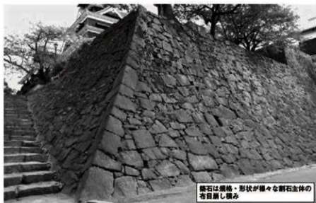
① 地藏権門石垣隅角部 (南西から)
