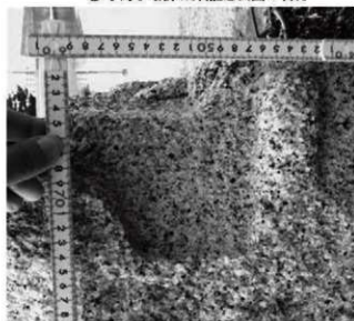
⑤ 同上、築石用材の矢穴 [標準サイズ]
