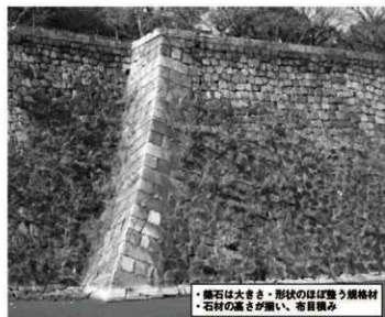
① 本丸東面月見櫓下隅角部 (南東より)
