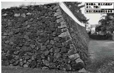
③ 本丸北東隅角部（東から）
