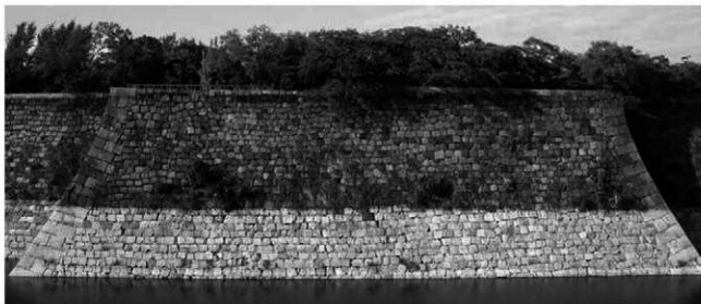
写真7 南外堀 藤堂家—細川家丁場
