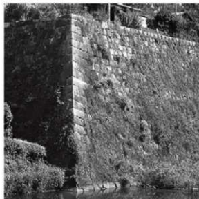
⑤ 本丸坤櫓隅角部 (南西から、寛永期)
