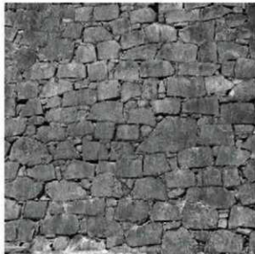
② 同左、築石部の拡大(東面) ※横目地が通る部分が多い
