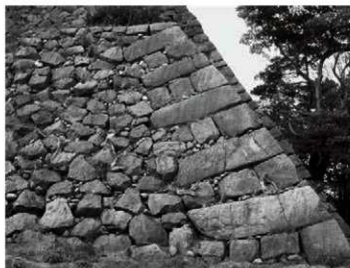
南面東端隅角部
