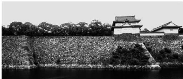
写真6 西外堀 黒田家・加藤家丁場
