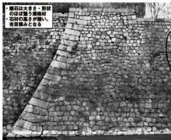
① 2期本丸東面隅角部（東から）
