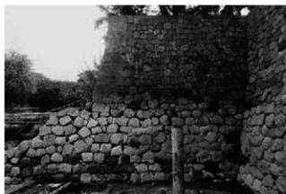
解体前の状況
