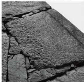
④ 同左、角石の表面は丁字な敲形による調整
