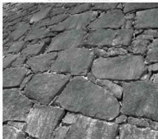
⑥ 同南面築石 (削石、面の整った野面石で平滑な面を構成する)
