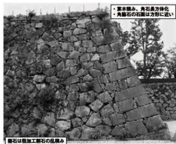
① 天守台北西隅角部（北から）
