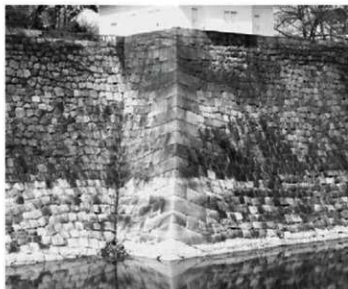
① 南外濠一番櫓下隅角部（南東から）
