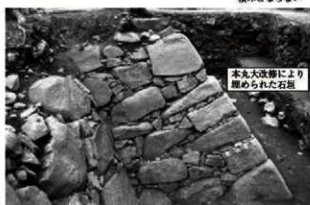
⑥ 名護屋城本丸旧石垣隅角部 削石による控えの短い算木積み 本丸大改修により 削められた石垣
