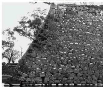
④ 大天守台北西隅角部（西から）
