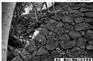
④ 名護屋城三ノ丸北西石垣隅角部 角石・斲石に加工石を多用 控えが短く、算木積みとならない。
