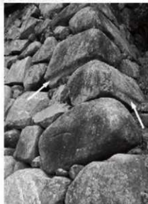
⑥ 同南西隅角部の拡大 〔切欠〕を伴う神籠石石材を多用
