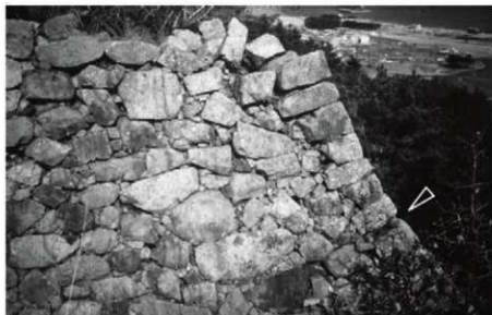
① 山上部 隅角部（積線に変化点がみられる）
