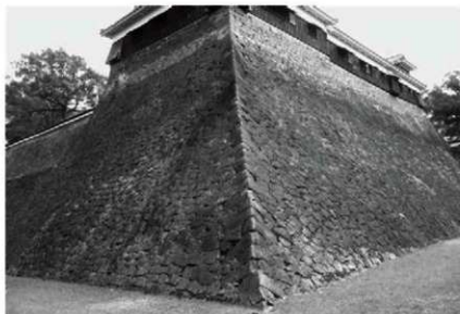
① 宇土櫓下隅角部 (北西から)
