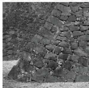
④ 同左、北西隅角部 (西から)
