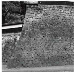
⑤ 平御櫓南東隅角部 (B-3類：南から)
