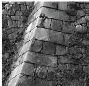
② 同左、2期隅角部の拡大（東から）
