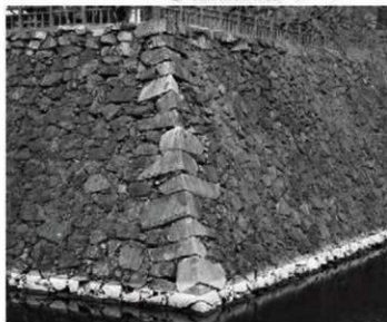
⑤ 本丸西面石垣隅角部（南西から）
