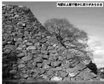
⑤ 小天守台南東隅角部 (南から)
