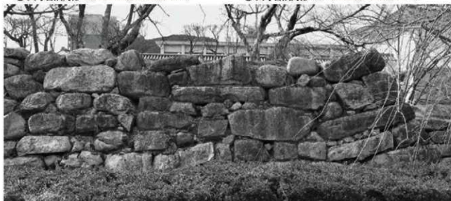
⑤ 天守台築石部（最上段は整備に伴う積み足し、一部旧村が残存。横長の石材を横位に配置し、横目地が通る部分が多い）
