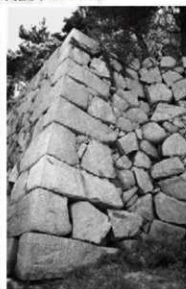
⑥ 本丸下曲輪西側隅角部
