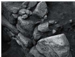
写真10 京都銀閣寺(慈照寺)境内排水溝：築石部
