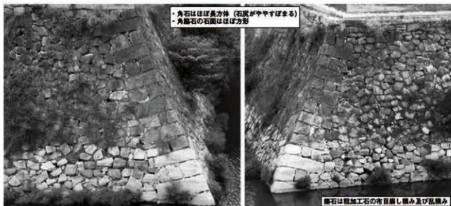
① 大坂城 1期西外濠隅角部 (東から)
