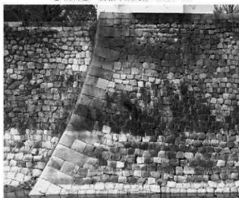
③ 南外濠一番櫓下隅角部（東から）
