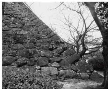
③ 大天守台北東隅角部 (東から)
