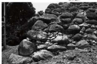
⑧ 名護屋城東出丸下北東隅角部 野面石による算木積み
