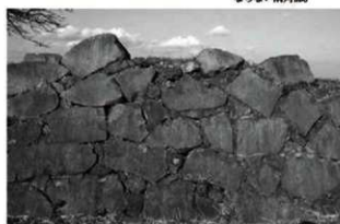
⑤ 名護屋城天守台東面斜面石垣 削加工石を主体とする 平面性の高い斲石
