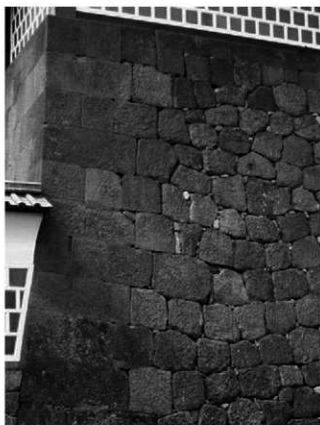
上部（文化期）隅角部（解体・修築後）
