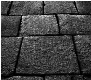
石面のスダレ状加工（北面）
