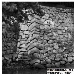
① 本丸東面石垣隅角部 (南東から)
