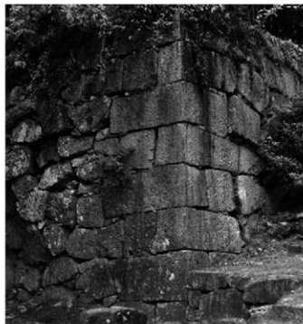
10. 新宮城松の丸隅角部
