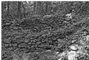
写真1 八王子城 御主殿西側の段構造を持つ石垣
