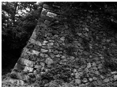
① 名古屋城山内家丁場 (二之丸西面隅角部)
