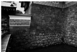
全景（北東から）
