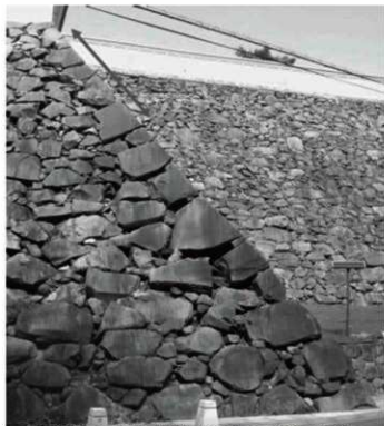
写真 29 甲府城 数寄屋檜台北東隅角部 (直線勾配)
