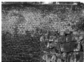
⑥ 若松城加藤家改修部分（本丸東面築石部）
