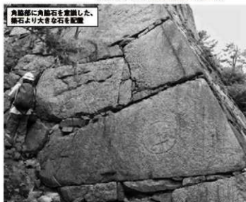
③ 同上、東面 (東から)
