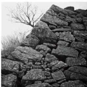
② 同左、隅角部拡大（角石は左右に控えをとる）
