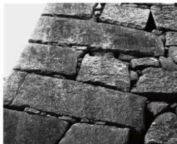
④ 南東隅角部（角石・角部石にみられる細かな表面ノミ調整）
