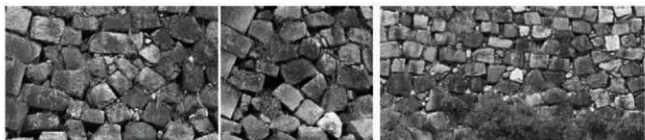
【乱積み主・大坂城1期】 ① 前田家 北外堀 多門橋下東側・青屋口北側 【布積み主・大坂城1期】 ② 前田家 北外堀 伏見橋下
