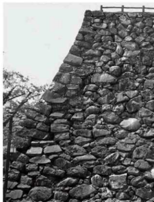
写真 27 甲府城 福荷檜台北東隅角部 (熊本型)
