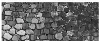
【布積み主・大坂城1期】 ⑤ 伊予加藤家 西外堀 坤橋下北側
