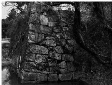
② 洲本城蜂須賀家改修部分 (下の城北面隅角部)
