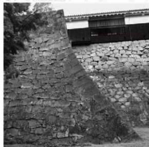
⑤ 数奇屋丸五階櫓下南東隅角部 (南から)
