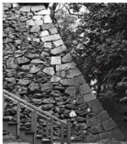
⑤ 南二の丸南西隅角部（西から）
