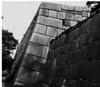
天守台石垣南西隅と小天守台西面
