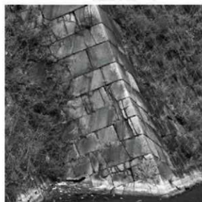
⑤ 同上、隅角部拡大 (南より)
