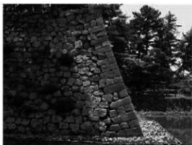
⑥ 津城藤堂家改修部分（本丸北西隅角部）
