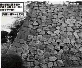
② 二之丸北東隅角部（北から）
