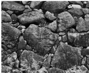
⑤ 本丸西南隅檜下築石部の刻印 (『重ね山形』が集中、西より)
