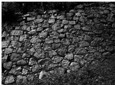
④ 松山城3期（南登り石垣築石部）
