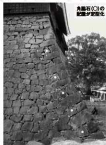
⑥ 小天守台北東隅角部（東から）
