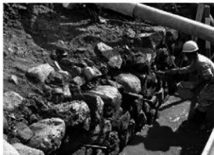
写真18 長崎出島石垣（後に補強列石）
