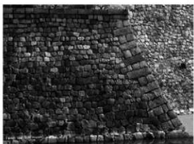
⑤ 大坂城2期加藤家丁場（本丸帯曲輪南西隅角部〔内堀〕）
