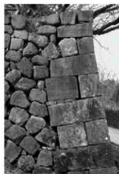
東面北端隅角部
