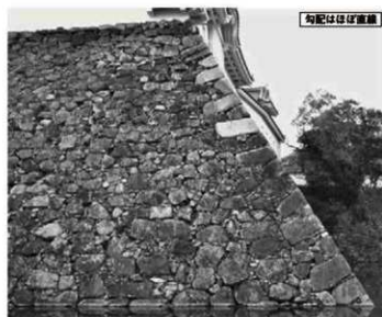
① 天守台北東隅角部 (東から)
