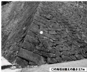
⑤ 平櫓下北東隅角部 (北から)
