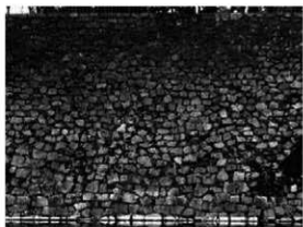
② 大坂城1期藤堂家丁場（西の丸北面築石部〔西外堀〕）
