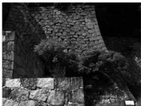
④ 松山城3期（西大砲台南東隅角部）
