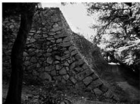
③ 松山城 2期（本丸北東隅角部）
