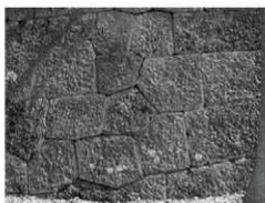
鉄門台北側築石部
