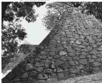
⑤ 本丸南東隅角部 (東から)
