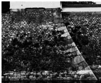
③ 西外濠千貫槽下隅角部 (熊本藩加藤家) 左：西面、右：南西より 角石は大型で、石面を広く見せる意匠的な配置がみられる ●
