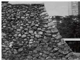
⑤ 高松城（本丸天守台北東隅角部）※解体前
