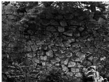
③ 上野城藤堂家改修部分（本丸西面築石部）
