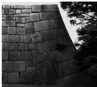
大天守台北西隅 北面
