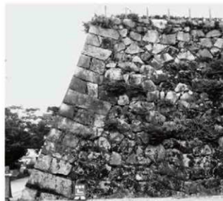
③ 天守台北西隅角部（西から）
