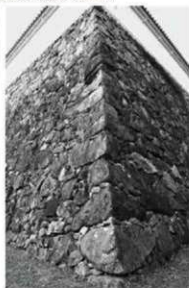
④ 同左、隅角部後縁（北東から）
