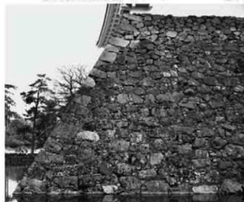
⑤ 天守台北東隅角部 (北から)
