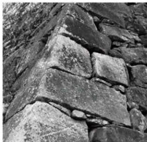
② 同左、角石・角脇石の拡大 （花崗岩割石で隅角部を構成）
