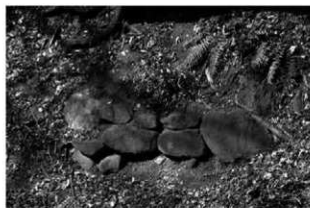
写真9 武田氏館 土壁法面の事例
