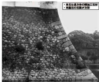
① 西外濠乾槽下隅角部 (北から)
