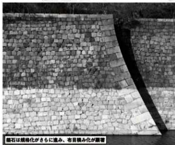
⑤ 3期南外濠隅角部（南から）
