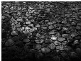
② 松山城 1期（東郭東面築石部）
