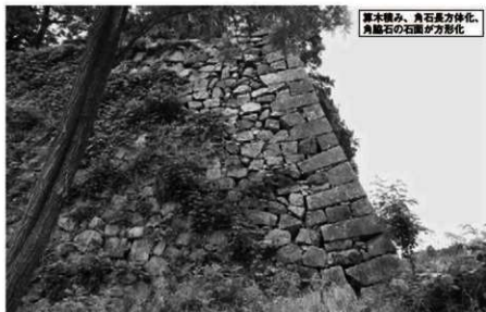
① 二之丸北東隅角部（東から）
