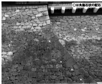
① 小天守台南西隅角部（西から）
