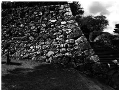
① 高知城 1 期（二ノ丸南東隅角部）
