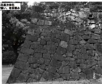
② 同東面 (A-2類 [控えの短い角石] →B-3類 [算木積み] への改修)
