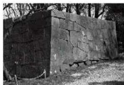
鉄門台北側 全景
