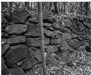
④ 鍋島直茂陣跡 曲輪石垣の築石部 (石面が揃い、平面性が高い)
