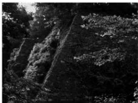
⑧ 上野城藤堂家改修部分（本丸北西隅角部）
