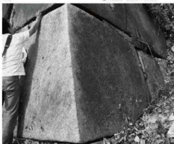
④ 同左、角石表面には丁寧なノミ調整が施される
