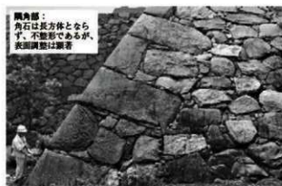
⑧ 名古屋城大天守台北東隅 (加藤家丁場：慶長15年) ※角石・角脇石に大型石材を使用
