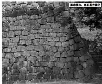
⑥ 同左、北東隅角部 (南東から) ※熊石の高さが揃う布目積み
