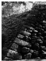
⑨ 高知城2期（三ノ丸北面隅角部）
