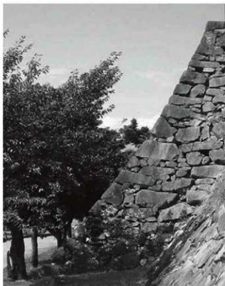
2. 本丸南面石垣（東から）
