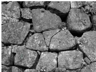
板状詰石の配置状況
