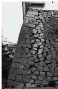
① 天守台南西隅角部 (南面)
