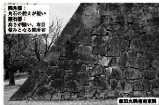
② 熊本城石垣 A-2 類 ※勾配が A-1 類より急である
