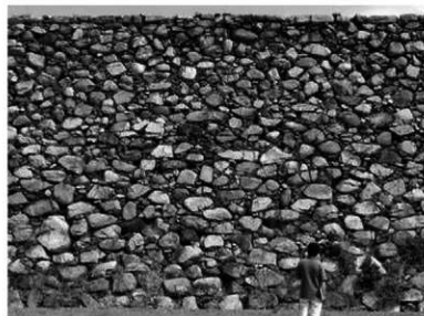
③ 高松城（本丸天守台南面築石部）※解体前
