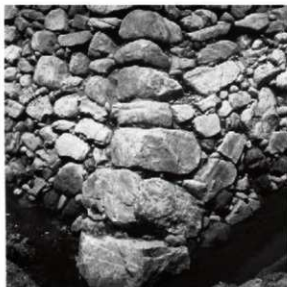
② 同左、角石部分拡大 (南東から)
