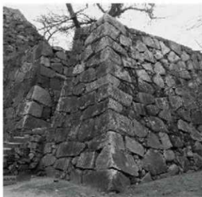
⑥ 天守台付櫓台（北東から）
