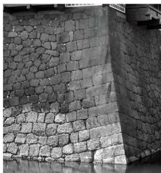
東面～北東隅角部
