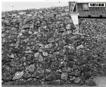
⑤ 本丸北西隅角部（北から）
