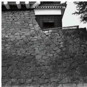
④ 大天守台南東隅角部 (西より)
