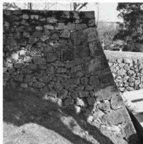
⑥ 大天守台南東隅角部（南から）
