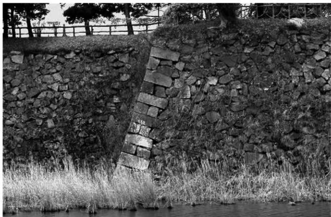
4b 二之丸北隅角部
