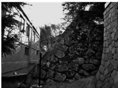
② 松山城 1 期（東郭東面隅角部）
