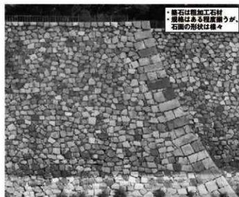
① 西外濠隅角部 (西から)
