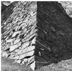
⑥ 同左 (南東から) ※下部は控えが長い
