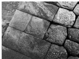
南面西端隅角部
