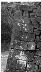
北面東端隅角部
