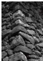
① 丑寅櫓下東側南東 1200S・E 1期
