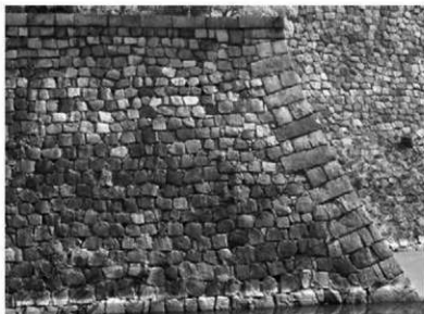
① 大坂城2期加藤家丁場（本丸帯曲輪南西隅角部〔内堀〕）
