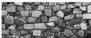
【布積み主・大坂城1期】 ⑥ 筑前黒田家 西外堀 千貫橋下北側
