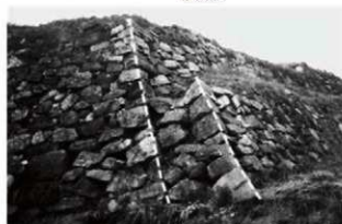
⑧ 横張倭城本丸隅角部
