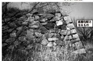
③ 西生浦倭城 山上部隅角部 直線勾配となるもの 控えが短く、算木積みとならない隅角部。
