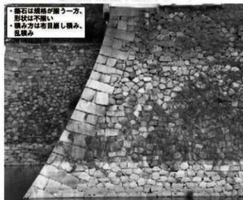
⑥ 同左、隅角部全体 (西から)
