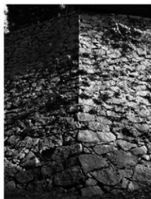
② 松山城2期 (本丸北面築石部)
