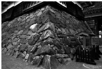
写真 30 松本城 天守台石垣北東隅角部
