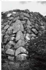
⑥ 縦石積みみの隅角部
