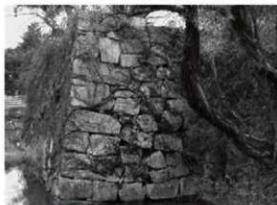
⑦ 洲本城蜂須賀家改修部分（下の城北面隅角部）
