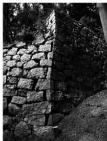
③ 松山城3期（南登り石垣隅部）
