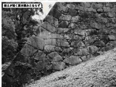
④ 百間櫓隅角部【A-2類】(南から)
