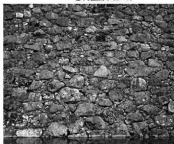
④ 天守台北面築石部 (北から：野面石による布目崩し積み)
