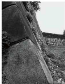
③ 大坂城2期藤堂家丁場（左：網張りの様子、中：加工された間詰め石、右：間詰め石のための角石への加工）
