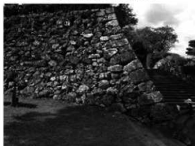
⑧ 高知城 1期（二ノ丸南東隅角部）
