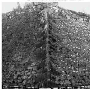
③ 大天守台北西隅角部（北西から）
