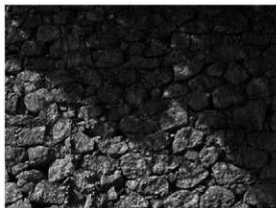
⑤ 松山城3期（西大砲台東面築石部）
