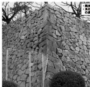
① 二之丸北東（萬櫓）隅角部（北東から）
