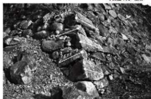
⑦ 名護屋城三ノ丸南東石垣隅角部 削石(根削石)による 控えの長い算木積み
