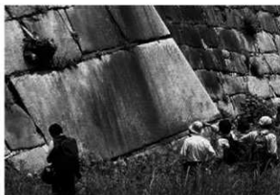
大坂城跡本丸西内堀の池田家丁場の隅角部
