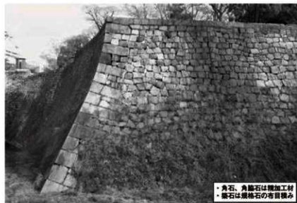
① 本丸西面具足方預片葺檐下隅角部 (西から)
