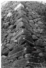
② 同左 (南東から) ※下部は控えが長い
