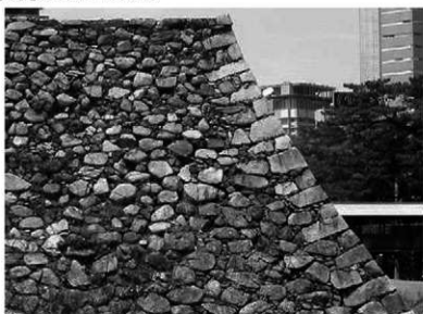
② 高松城（本丸天守台北東隅角部）※解体前
