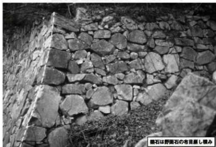
⑤ 山上部 隅角部（角石の控えが短く、積線に僅かに「反り」がみられる）
