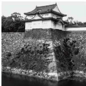
① 西外濠千貫槽下隅角部 (南西から)
