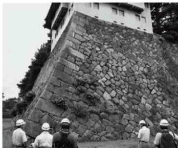
② 同左、大正年間にほぼ全面を改修 (南より)
