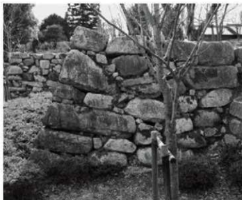
② 天守台隅角部（最上段は整備に伴う積み足し）
