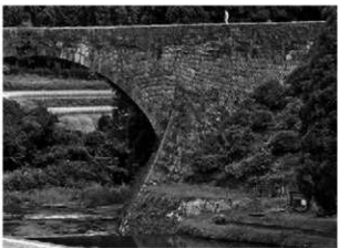
写真19 通潤橋石橋と朝石垣
