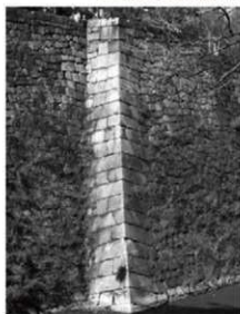
③ 同上、2期隅角部（南東から）
