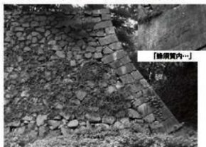
③ 名古屋城蜂須賀家丁場（本丸大手馬出南東隅角部）
