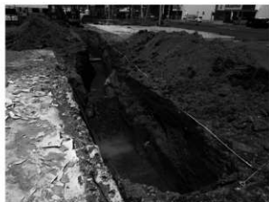
写真9 1トレンチ (南西から)
