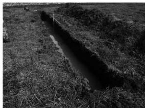
写真 21 12 トレンチ (西から)
