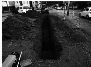
写17 1トレンチ（北から）
