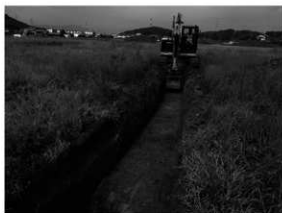
写真 23 1トレンチ (東から)
