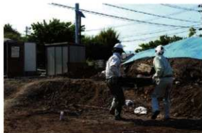
コンクリート片搬出
