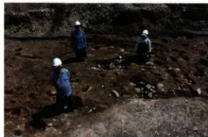
ST1 完掘状態
