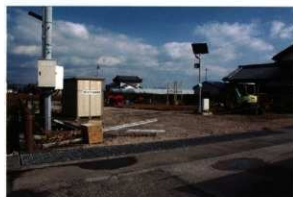
遊具等撤去作業中 (2014. 3. 6)
