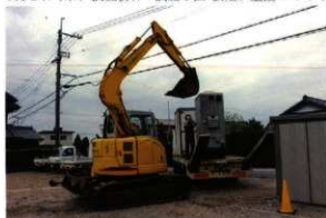
コンテナ・仮設トイレ搬入
