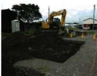
埋め戻し作業
