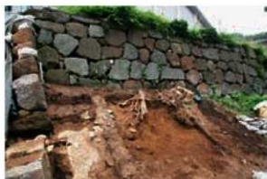
断面No.8・9 B面スノ 全景
