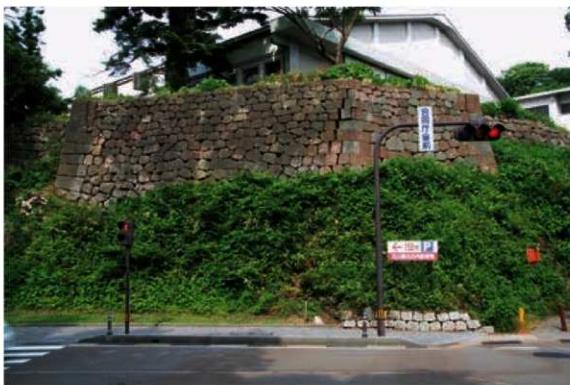
C・D面 調査着手前（平成16年）
