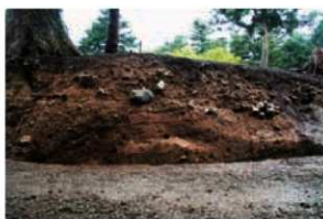
断面No.22 東側法面 2
