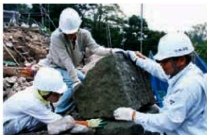
石材取り外し
