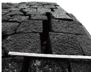
写真1-3 修築前玉泉院丸石垣 変状状況
