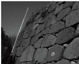
写真1-3 修築前玉泉院丸石垣 変状状況
