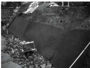
写真 6-18 吸出防止マットの敷設
