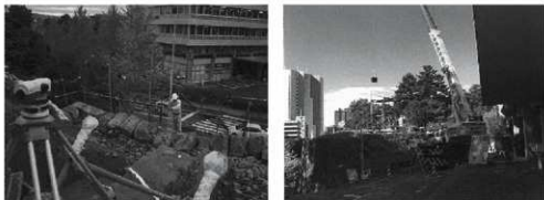
第3-15図 解体時写真測量状況（左：標点測量、右：写真撮影）
