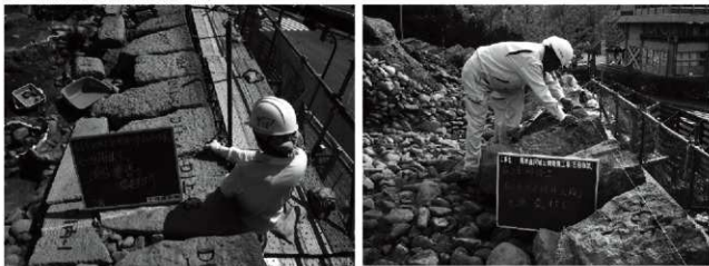
写真6-5 解体前の石材処理
