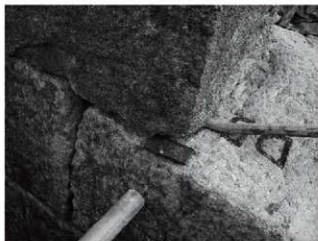
写真6-15 詰石やプレート挿入による石材姿勢の調整
