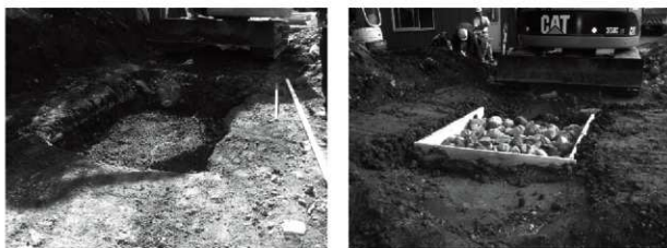
写真 6-10 栗石材料試験の試験ヤード設置状況
