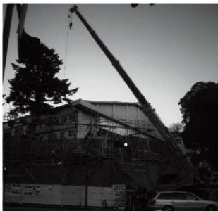
写真 6-20 足場仮設状況
