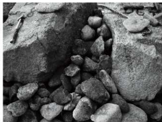
写真6-16 詰石等による石材（築石）の固定
