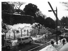
HI17.12.23 大型土のう積み 着工
