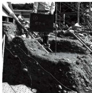
写真3-2 簡易動的コーン貫入試験状況
