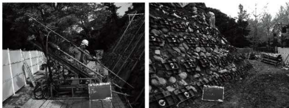
写真6-22 鉄筋挿入工 施工状況
