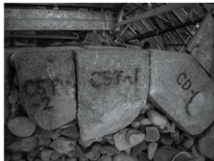
写真6-16 詰石等による石材（築石）の固定
