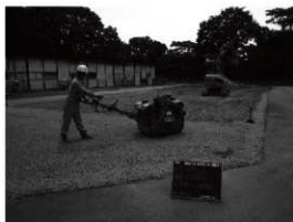
写真 6-2 石材仮置き場整備
