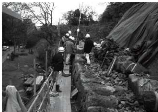
写真 6-13 丁張り設置状況
