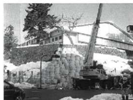
HI17.12.24 大型土のう積み 完了(13段)
