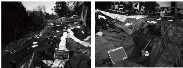
写真6-9 掘削面保護・雨水処理状況
