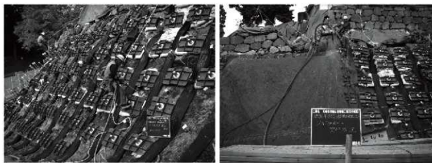
写真6-23 連続繊維補強土工 施工状況
