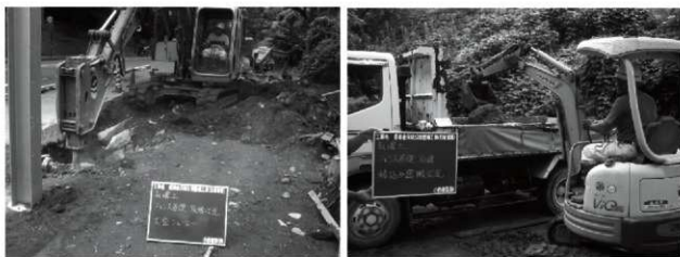
写真 6-24 防護柵等の仮設物撤去状況
