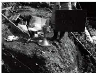
写真3-3 現場密度試験状況
