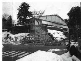
HI17.12.29 保護シート、ロックネット設置完了
