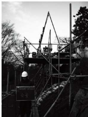
写真3-1 ボーリング実施状況
