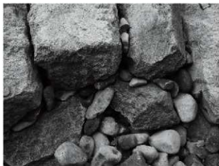
写真6-16 詰石等による石材（築石）の固定
