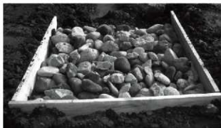
①緩詰め状態 落とし込みで充填
