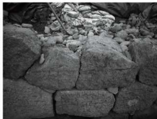
写真6-15 詰石やプレート挿入による石材姿勢の調整
