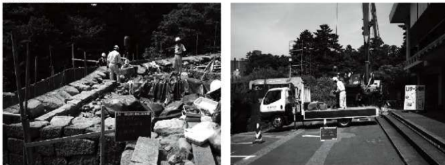
写真6-6 石材解体状況
