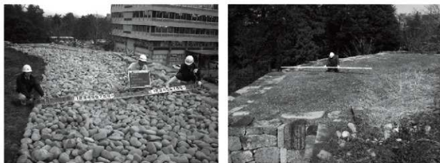
写真6-21 天盤部施工状況
