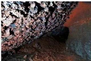
隧道内現況(出口より30m・トレンチ1付近) 北東から
