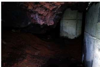
隧道内現況 (出口より35m) 北東から
