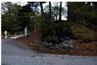
編福穴現況(出口側) 北から
