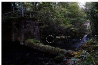
福地用水路の堰と蝙蝠穴取水口 南から
