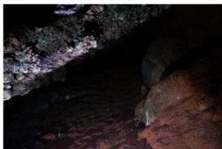
隧道内現況 (出口より40m) 北東から
