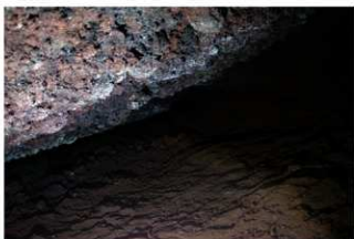
隧道内現況 (出口より45m) 北東から
