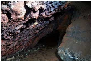
隧道内現況(出口より20m) 北東から
