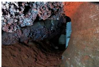
隧道内現況 (出口より32m) 北東から
