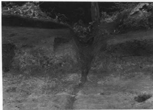
2. 4号整穴排水溝
