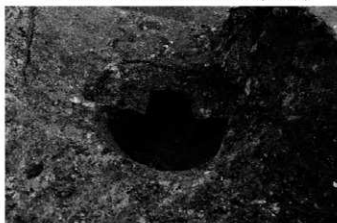
100号掘立柱建物跡 112号ビット掘方土層状況 (西から)
