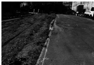
4 A～Fトレンチ予定地の舗装道路撤去後(北西から)
