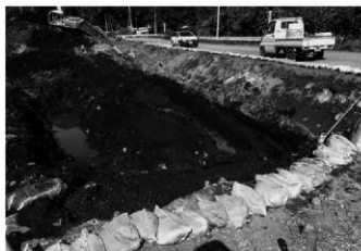
8 II区全景 南東から
