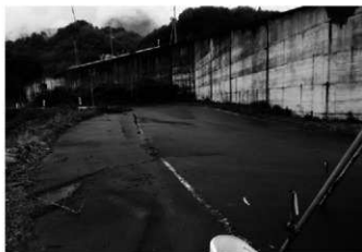
3 A～Fトレンチ予定地の舗装道路撤去前(北東から)
