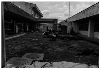
5 5区(調査前の状況)
