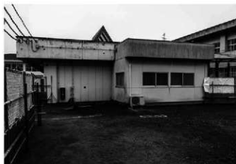
5 2区(調査前の状況)
