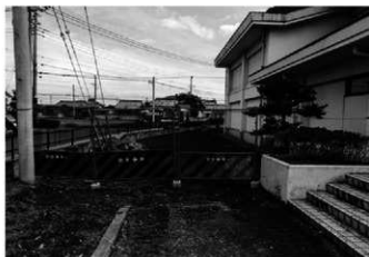
1 3区(調査前の状況)
