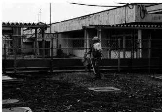
3 4区(調査前の状況)
