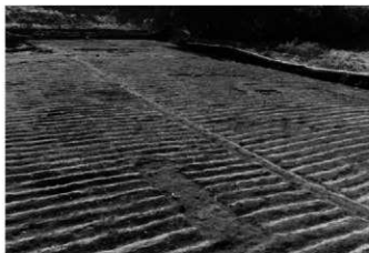
6 5号道 北東から
