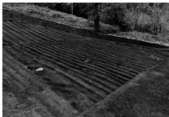
5 2号～4号復旧坑群南部 南東から
