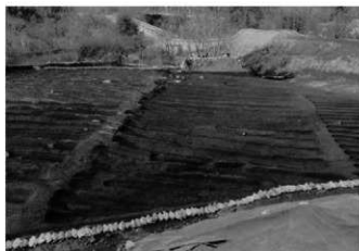
5 5号～8号復旧坑群 南から
