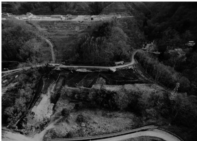
1 遺跡遠景 平成27年度調査(5～9号復旧坑群) 北から
