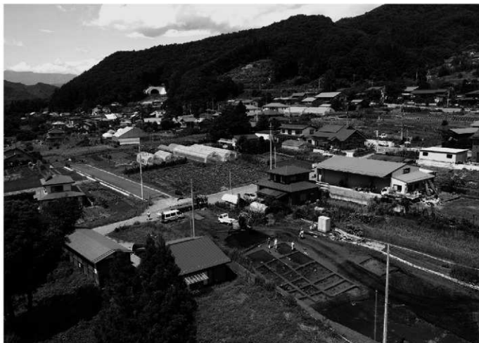
1 51区遠景 調査着手時(東から)
