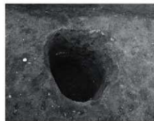
8 3区P207全景(南から)
