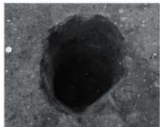
12 3区P97全景(南から)
