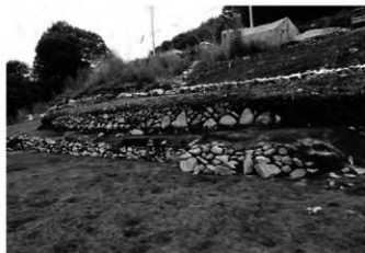
5 A区1面4号石垣全景(南東から)
