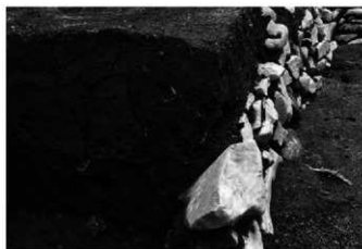
6 A区1面5号石垣断面(西から)
