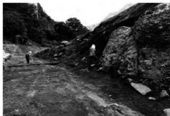
4 B区1面3号道調査風景(西から)
