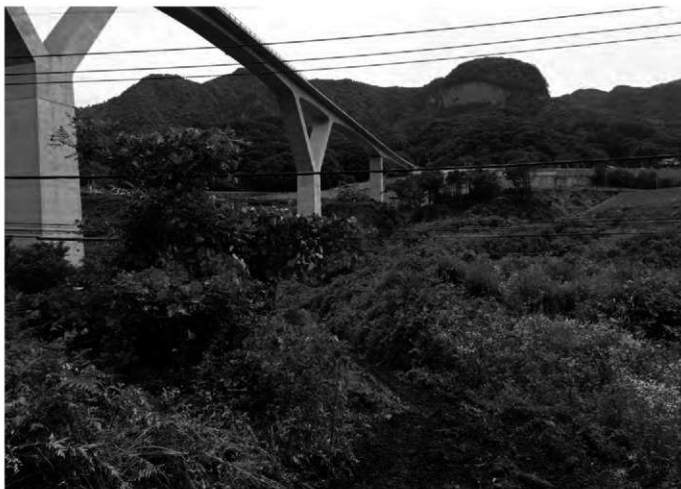
1 B区調査前全景(奥に丸岩) (北東から)
