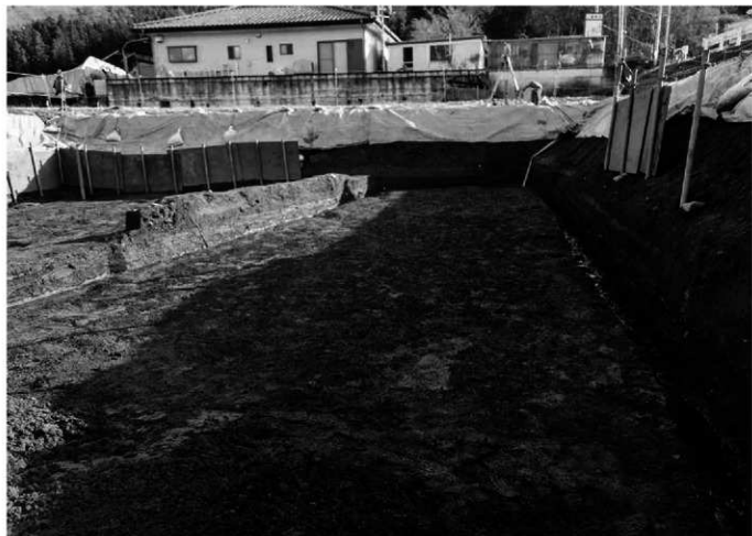
2 8-2区2面下全景(北から)
