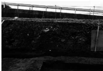
4 8-2区西壁土層断面C-C' (東から)
