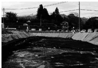
2 4区中区1面5・6号水田、5号畦畔検出状況(東から)
