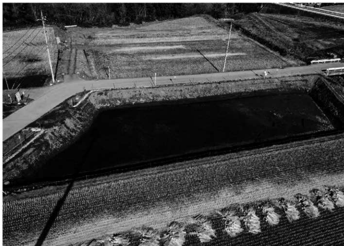
1 4区北区2面全景(南から)
