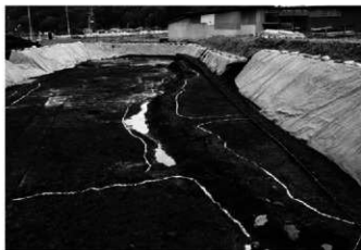
5 4区中区1面1号溝、4号畦畔検出状況(西から)
